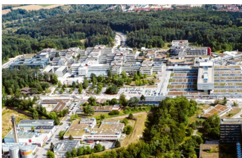
Die Wissenschaftsstadt samt Uniklinik auf dem Ulmer Eselsberg wurde in den 1980er Jahren gebaut und seitdem stetig erweitert.
